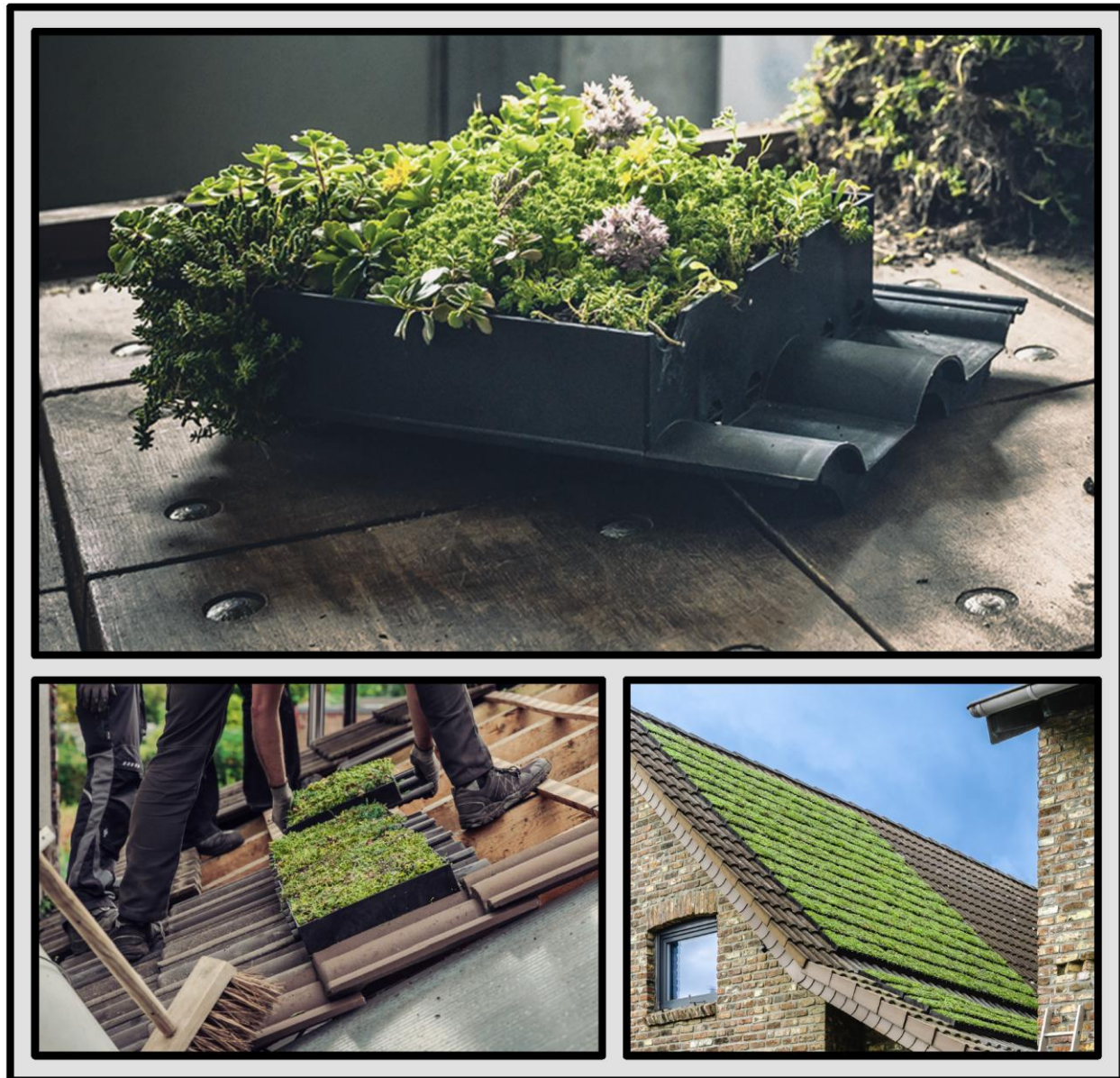
Abbildung 15: Vorbegrünter Gründachziegel (oben), Montage der Gründachziegel (unten links) und mit Gründachziegel begrüntes Schrägdach (unten rechts) (Quelle Abbildung: IPO, Quelle Bilder: https://mygreentop.de/mygreentop-schraegdachbegruenung/ )
